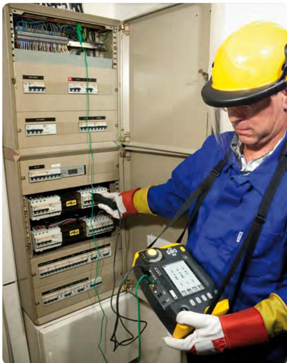
Dans le domestique, le tertiaire ou l'industrie, les nouveaux contrôleurs d'installation multifonction permettent de **vérifier la conformité d'une installation électrique selon les normes en vigueur**. Cette vérification est obligatoire pour obtenir quel que soit le type de bâtiment testé (domestique, bâtiment public, industrie...)
